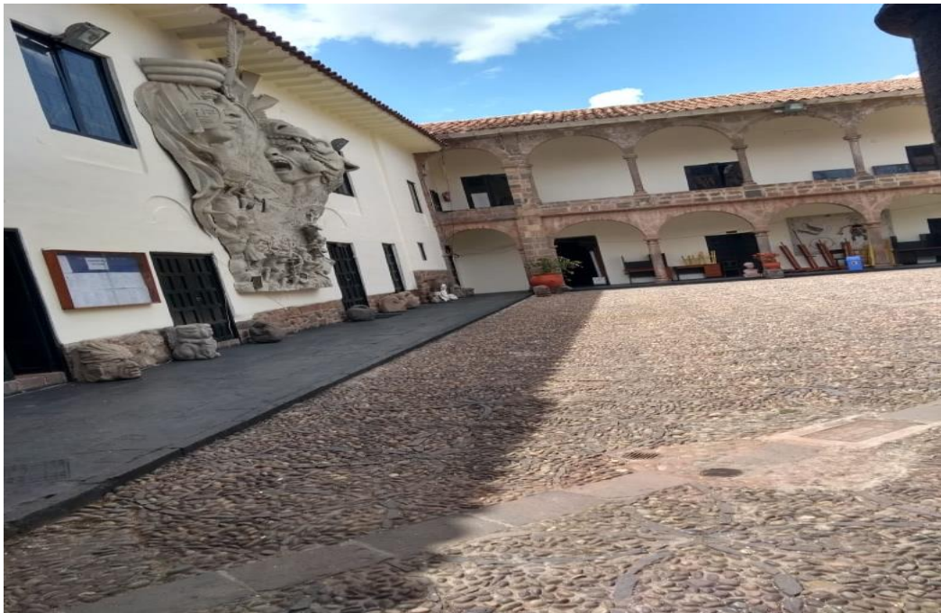
Figura 14 Lugar de esparcimiento en la UNDQT
