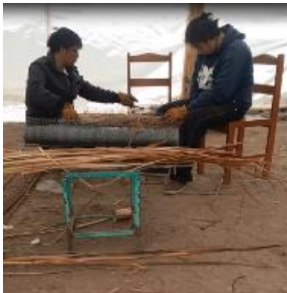
Amarrado de la totera con malla metálica.
