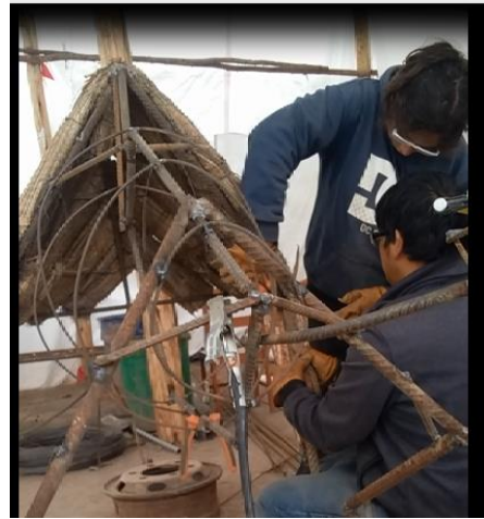
Forrado de la estructura con la totera.
