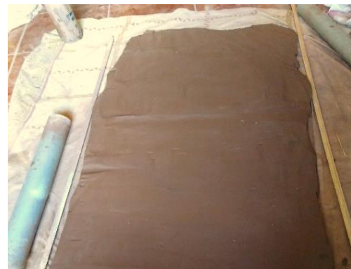
Figura 8: Nivelación de la pasta con ayuda de regletas.
