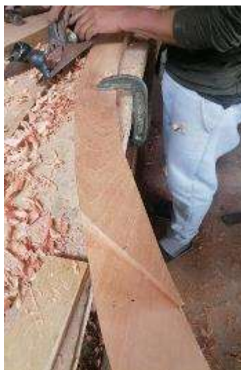
Figura 148: Realización de los nuevos bastidores en el taller privado por el especialista utilizando los materiales adecuados, en madera de cedro.
