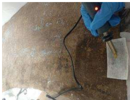
Figura 96: Detalle del uso de calor utilizando espátula térmica
