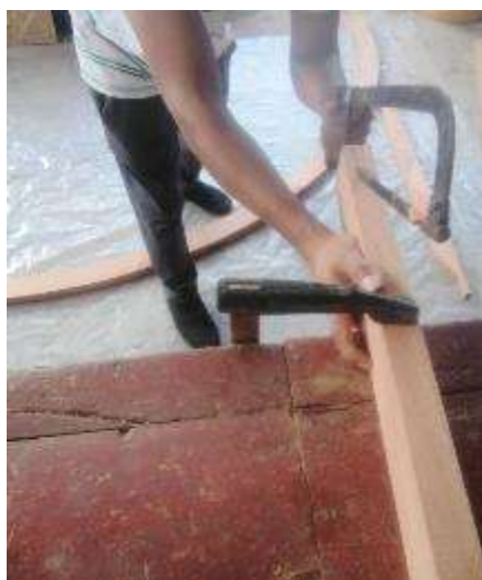
Figura 147: Realización de corte de listones previamente lijados por el especialista Carlos Mamani Huillca
