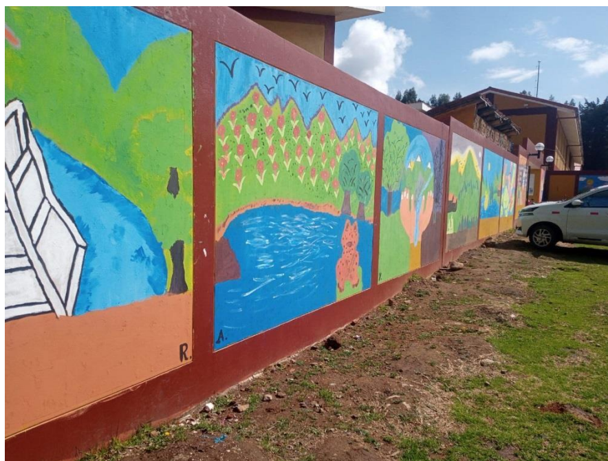
Figura A16: Trabajos concluidos
