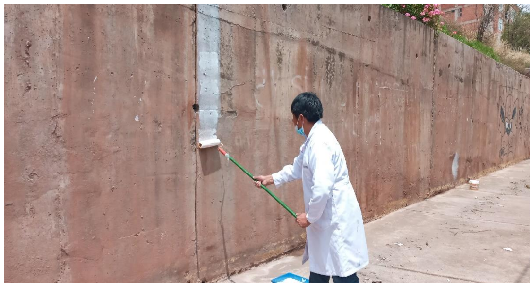
LIMPIEZA Y SELLADO DEL MURO
