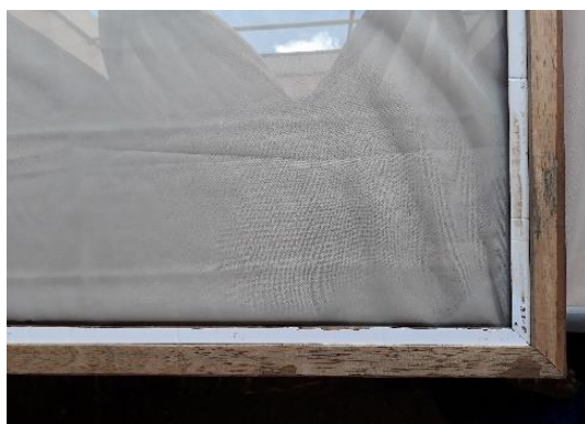
Figura 94: Detalle del filete de foam aislante.
