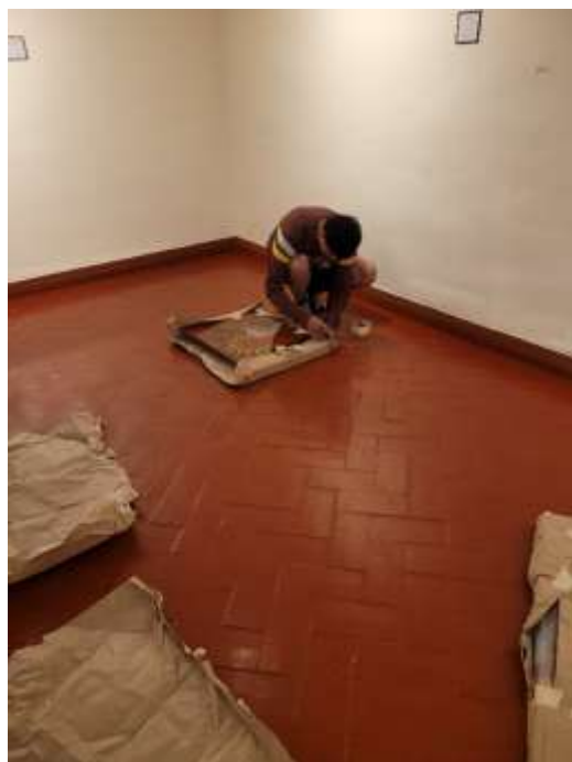
Figura D 17 Desmontaje 3
