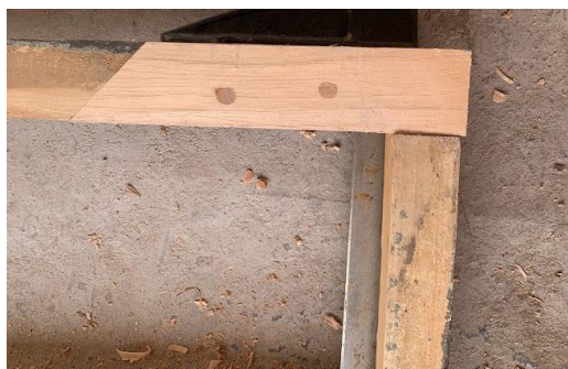
Figura 92. Visualización de injerto con clavijas de madera.
