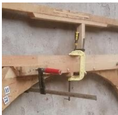
Figura 93. Consolidación de madera.
