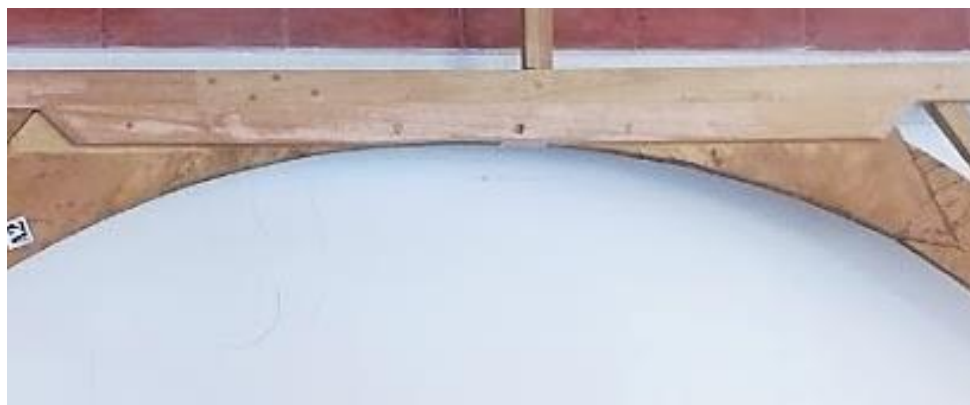
Figura 98. Refuerzo de madera en el centro del bastidor.
