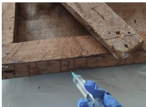
Figura 79. Aplicación de preservante de madera.
