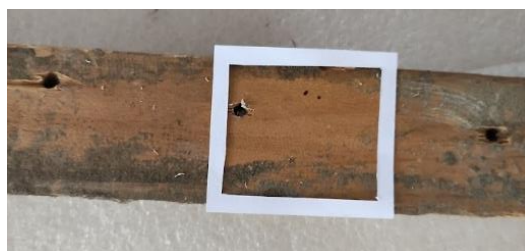
Figura 83. Señalización de zona limpia con ventana de papel.
