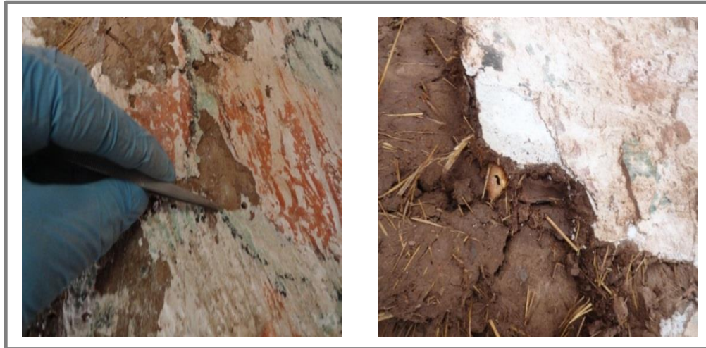
Figura 51: Perfilado de lagunas Nota: Registro propio
