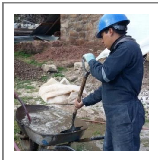
Figura 58: Lavado de arena Nota: Registro propio
