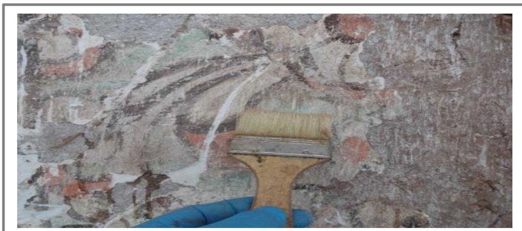
Figura 49: Registro general y de detalle del estado inicial Nota: Registro propio
