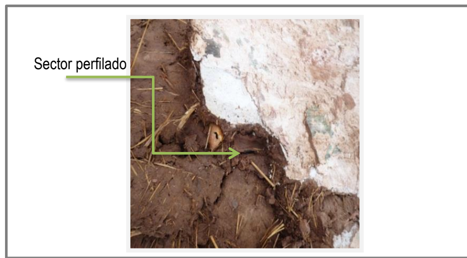
Figura 54: Perfilado del embarre fatigado Nota: Registro propio
