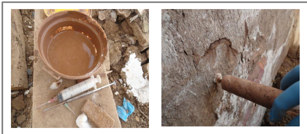
Figura 52: Consolidación de enfoscado Nota: Registro propio
