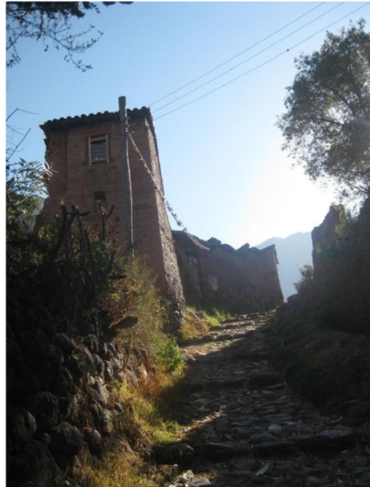
Figura 18. Calzada empedrada “Yucay/Urubamba” Fuente propia (abril 2018)
